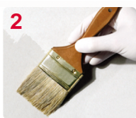
2 APLIQUE SELLADOR FIJADOR
