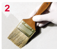
2 APLIQUE SELLADOR FIJADOR
